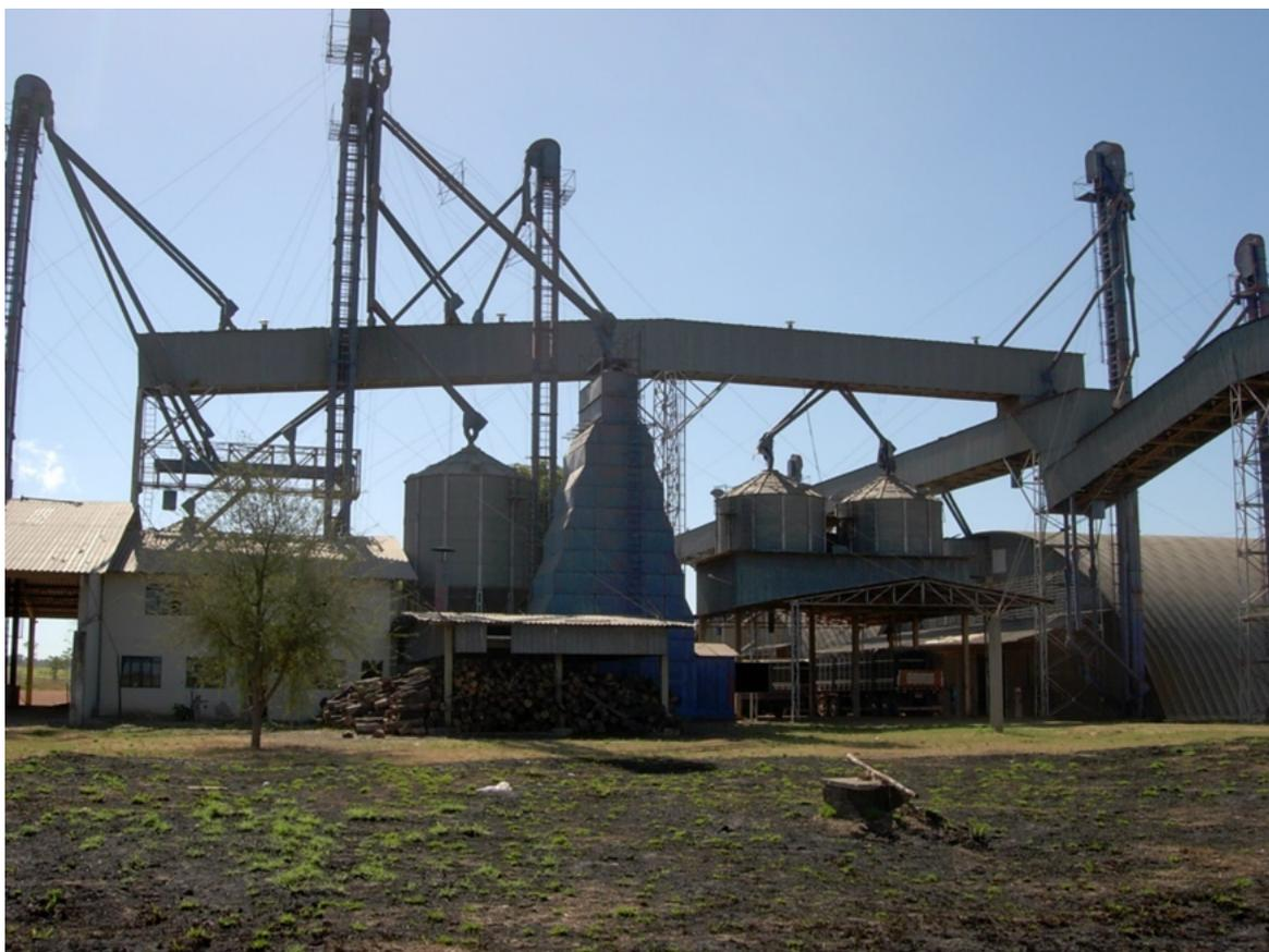
Vista posterior da casa de máquinas (moega, silos, secador, galerias superiores)
