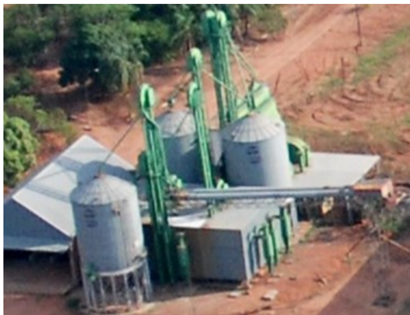
Central de Processamento 2, com vista das moegas, elevadores e as duas linhas de fitas.
