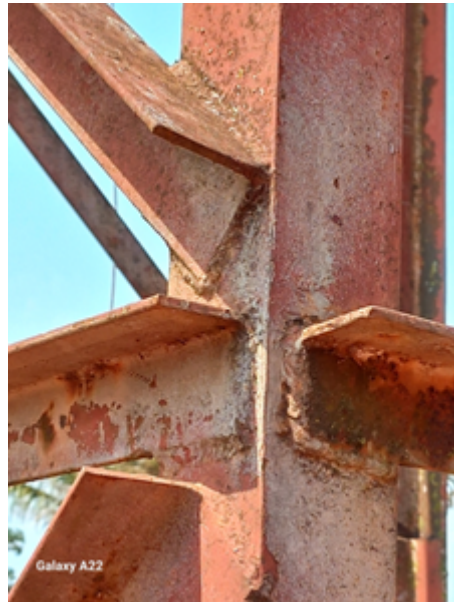
detalhe da estrutura das passarelas
