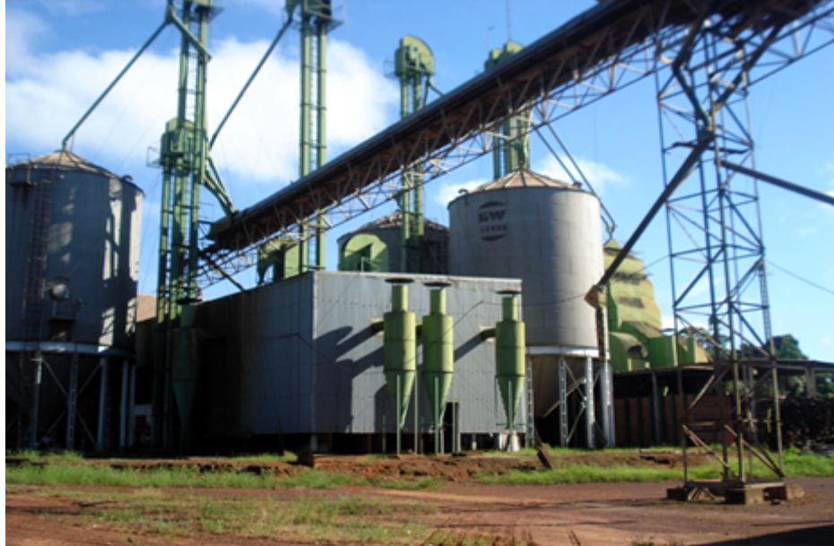
Central de Processamento 2 RECEM 05/2015
