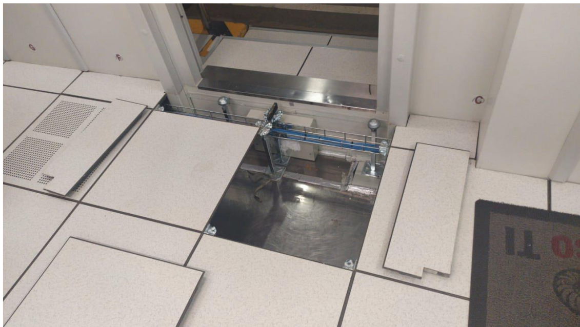
Figura 02: Remoção da blindagem.
