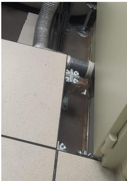
Figura 03: Remoção da blindagem.
