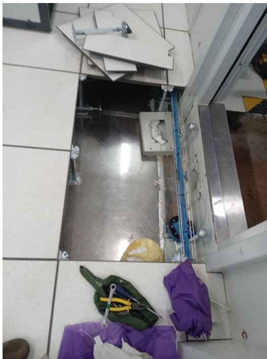
Figura 02: Remoção da blindagem.
