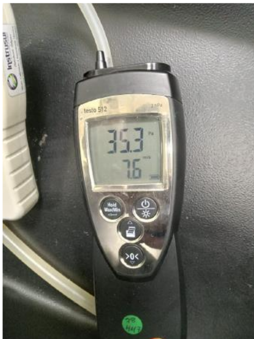
Figura 16: Início da despressurização.
