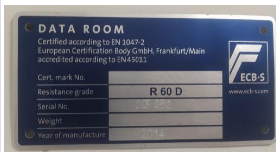
Figura 02: EN 1.047-2 da Sala Cofre
