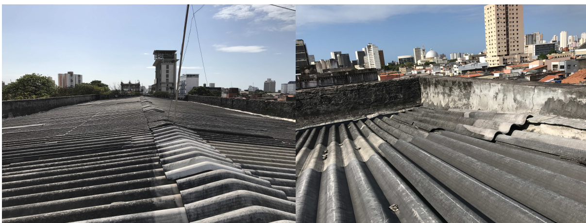
Figura 3: Cobertura e calhas do 2º Pavimento.
