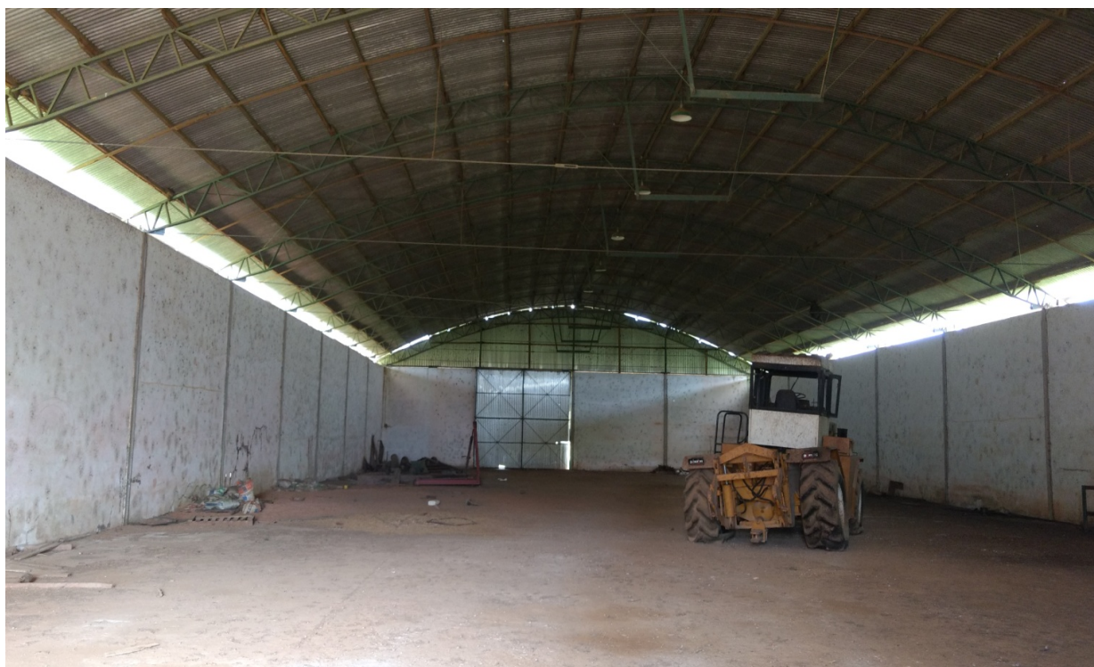
Foto 04 – Vista interna do armazém pré-moldado
