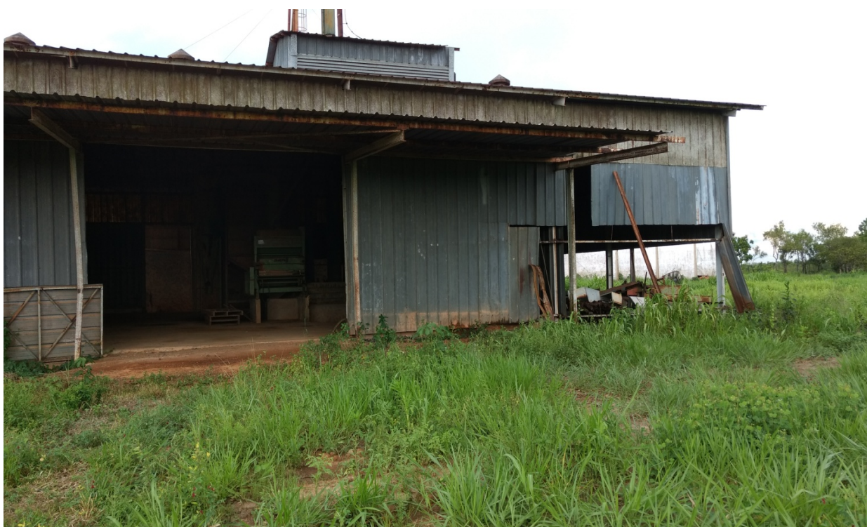
Foto 08 – Vista lateral do armazém metálico e marquise sobre portão de recepção/expedição
