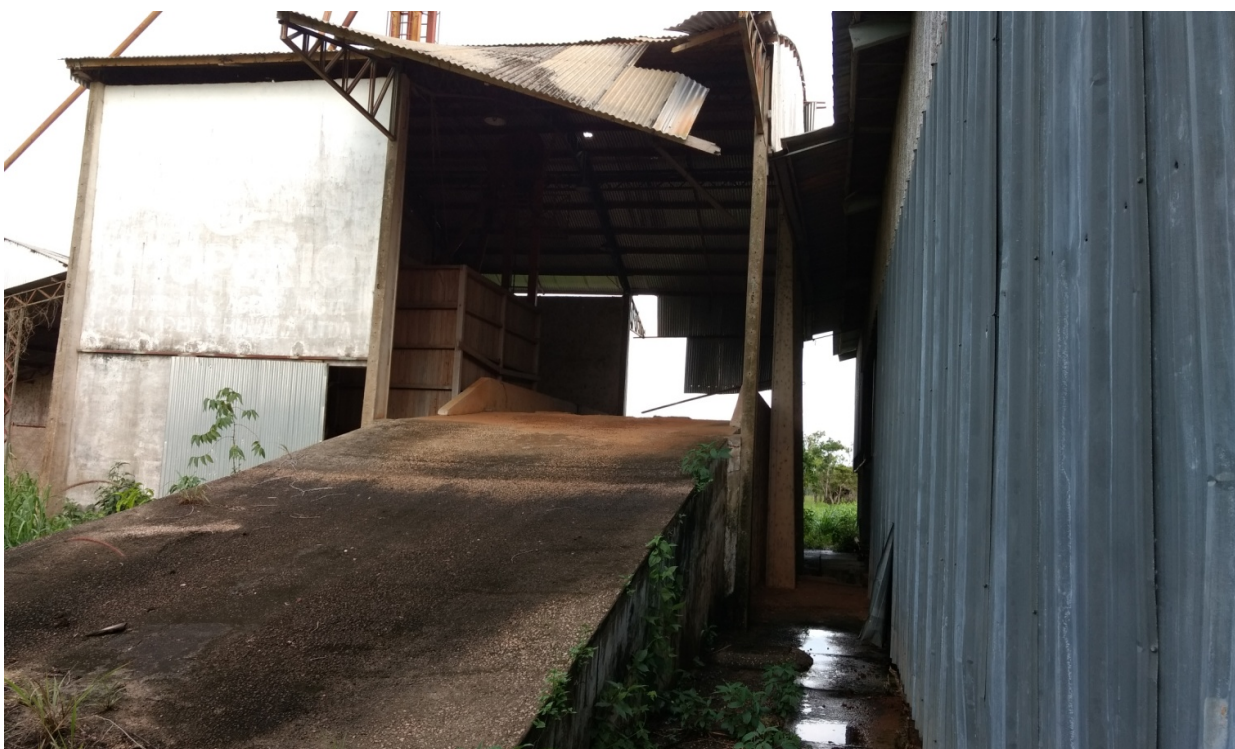
Foto 07 – Vista externa da moega graneleira e a rampa de acesso
