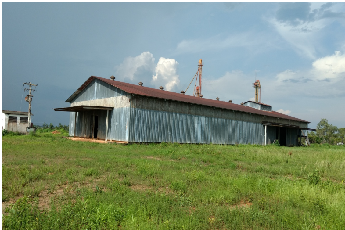
Foto 01 – Vista geral da fachada principal do armazém metálico
