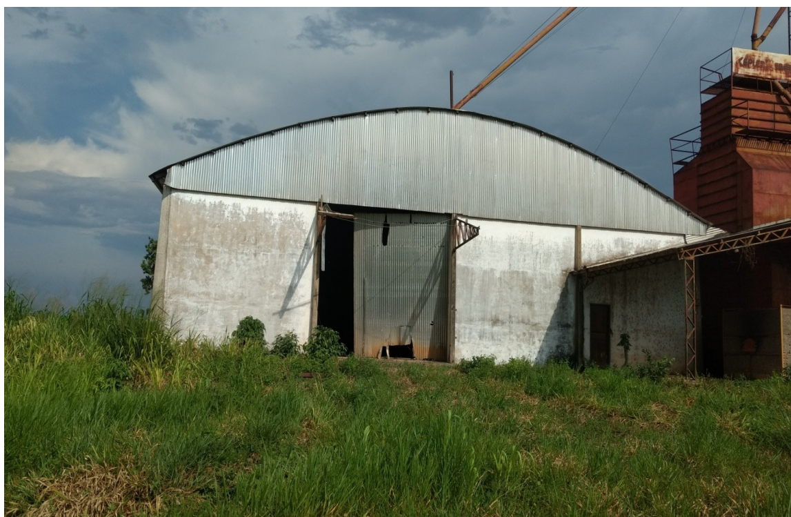
Foto 02 – Vista frontal do armazém pré-moldado e secador de grãos na lateral
