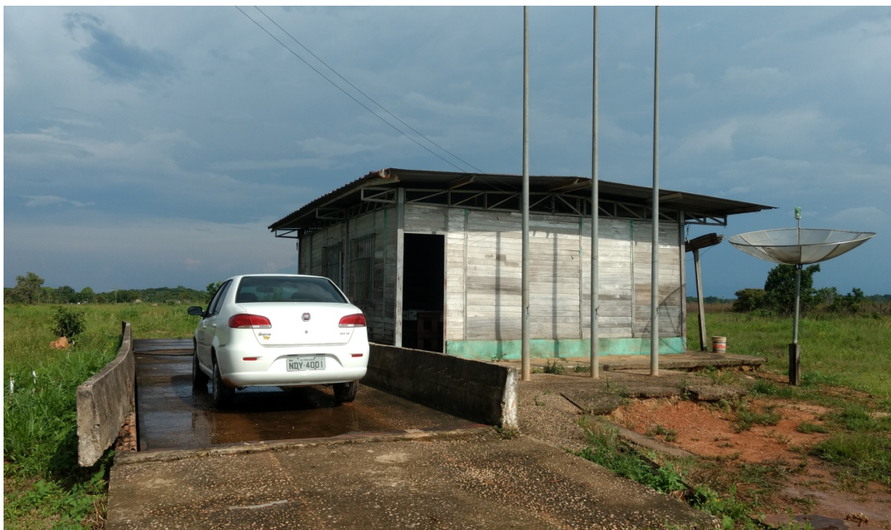
Foto 05 – Vista do escritório e plataforma da balança rodoviária
