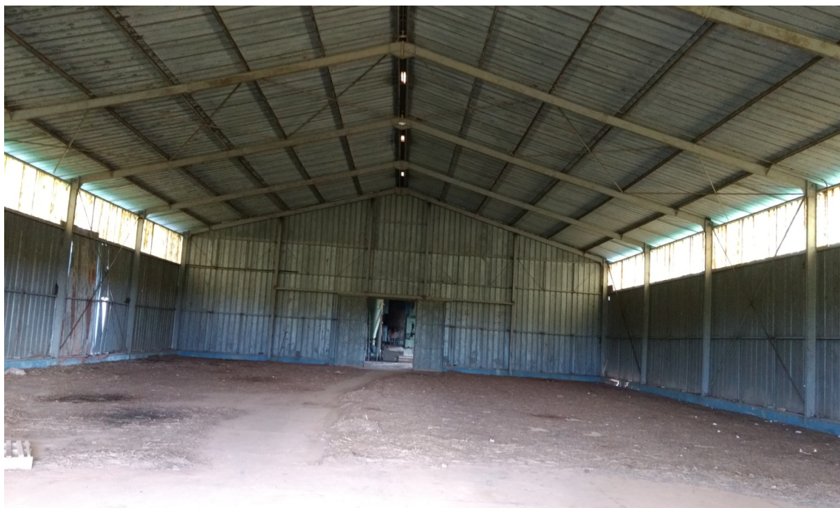
Foto 03 – Vista interna do armazém metálico
