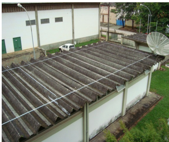
Figura 5: Exemplo construtivo da Gaiola de Faraday em edificações deste subitem.
