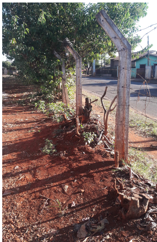
Foto 04 – Trecho 2 , conforme o croqui do Anexo III
