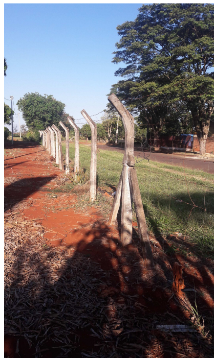
Foto 05 – Trecho 3 , conforme o croqui do Anexo III
