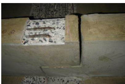
Figura 02: Exemplo de delimitação no concreto
