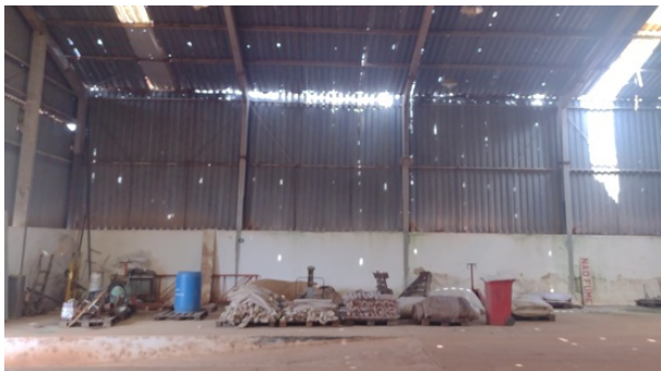
Figura 03: Tramas do fechamento lateral a serem substituídas.
