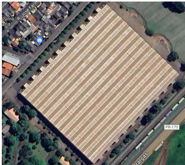
Figura 01: Cobertura da Unidade Armazenadora de Rolândia
