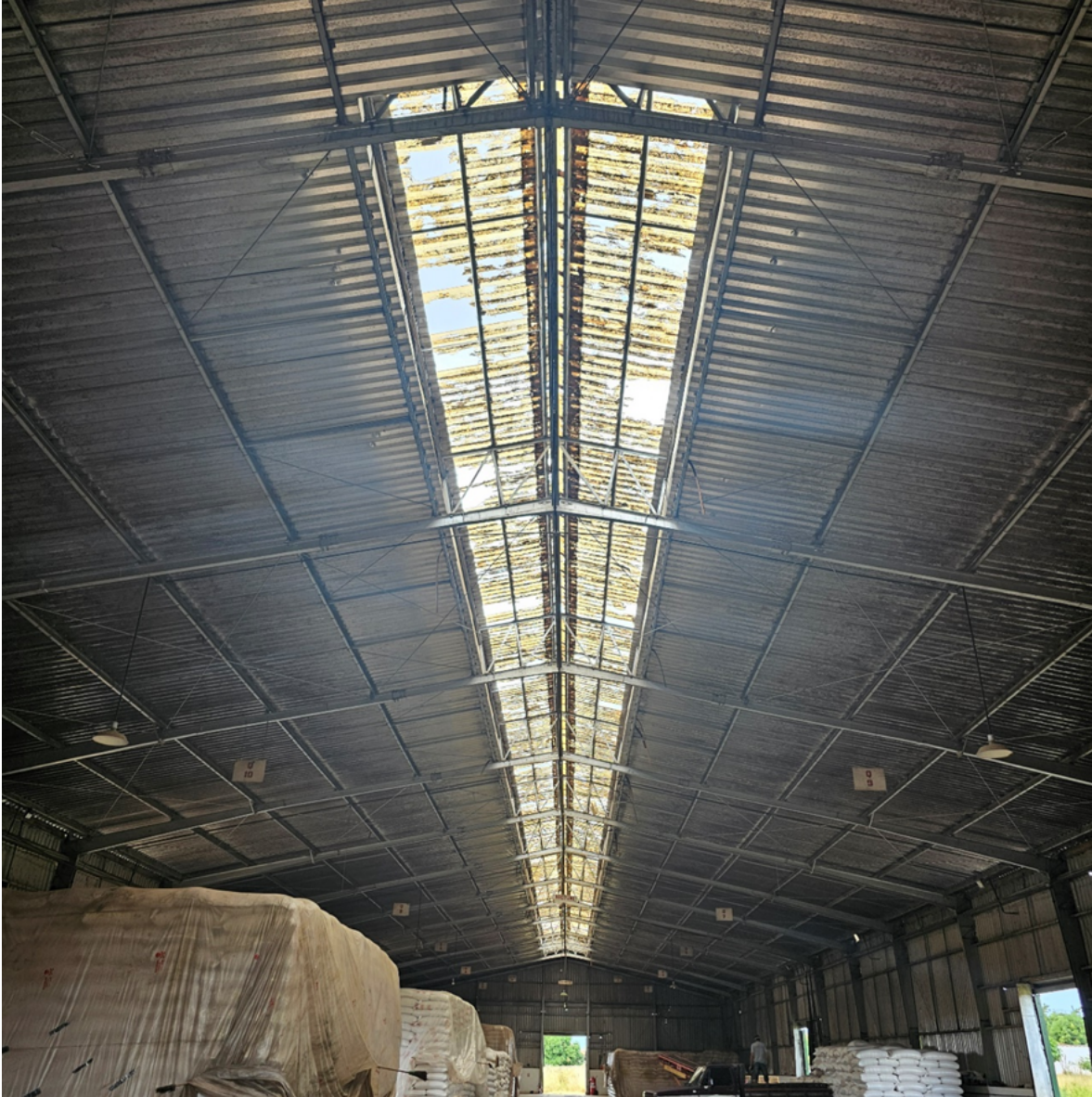
Figura 01: Foto interna do Sistema de Lanternim
