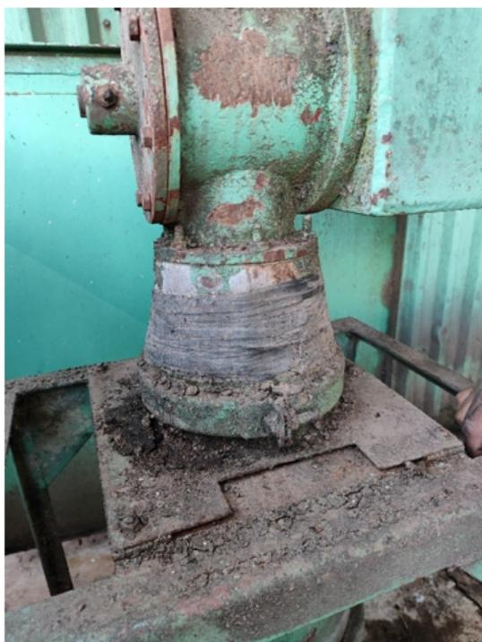
Fig. 7. Peça de ampliação com avançado grau de oxidação, na saída do sistema de captação de pó.
