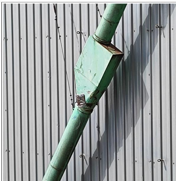
2.5. Nas atividades rotineiras de armazenagem de grãos tem-se as operações de transbordo, na qual é realizada a remoção de grãos dos fundos das células de armazenagem por meio de dutos e conexões. Esse processo é abrasivo e gerou furos nos dutos e suas conexões. Os vazamentos nos dutos geram perdas dos grãos e prejudicam a segurança dos operadores, que normalmente ficam próximo ao caminhão, na parte inferior dos dutos de transbordo.
